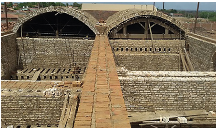
Forno de Múltiplas Câmara em Construção - Projeto de Inovação SENAI SESI - Itajá-RN
