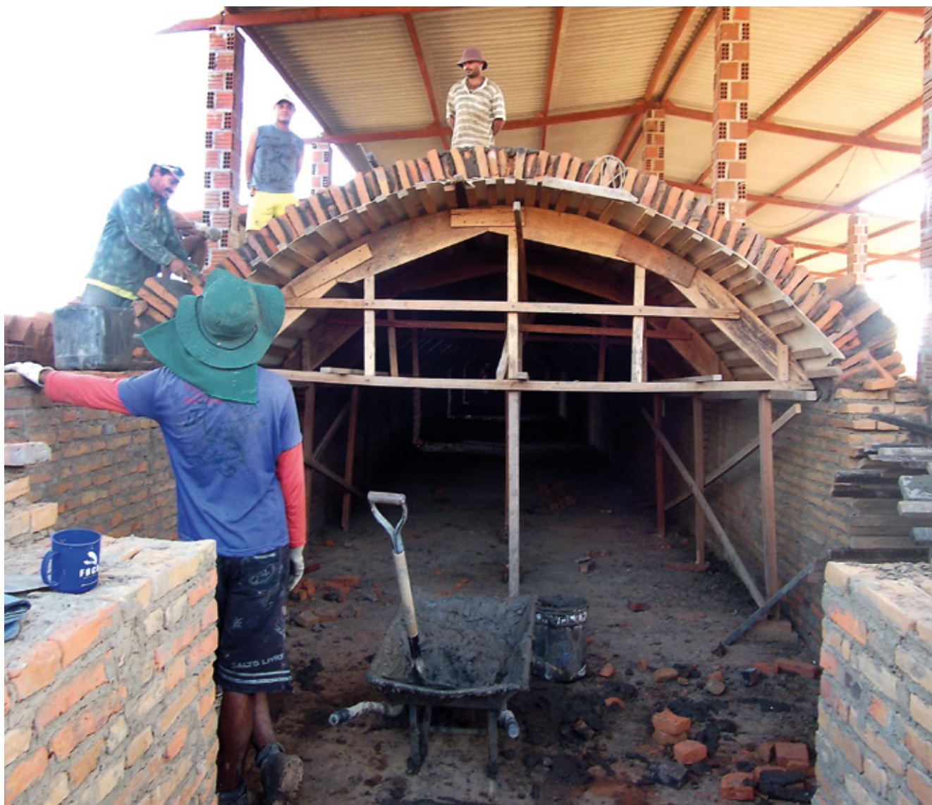
Forno Hoffmann em Construção - Cerâmica em Tangará-RN
