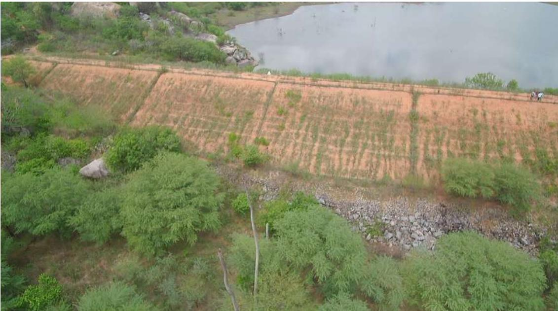
*Figura 8: Deslocamento do enrocamento*
