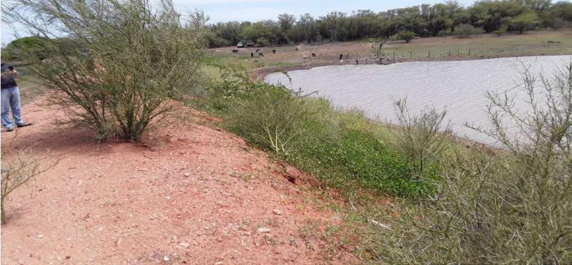
*Figura 7: Crescimento da vegetação na parede*
