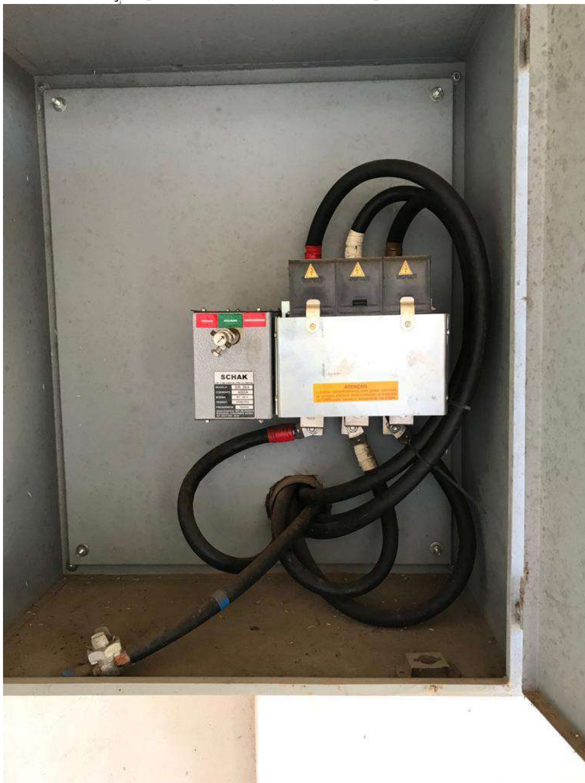
Foto 21 – Painel Elétrico de Intertravamento entre a energização Cosern e a Geração de Emergência.
