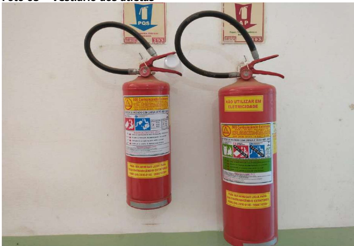
Foto 04 – Extintores mantidos e dentro do prazo de validade.
