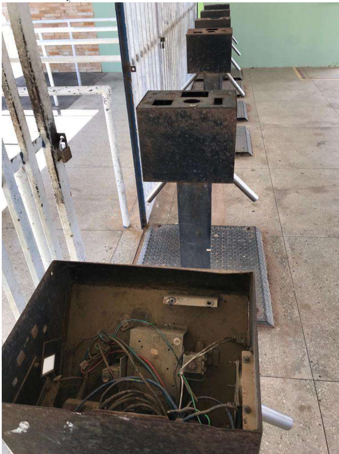
Foto 02 – Catracas deterioradas.
