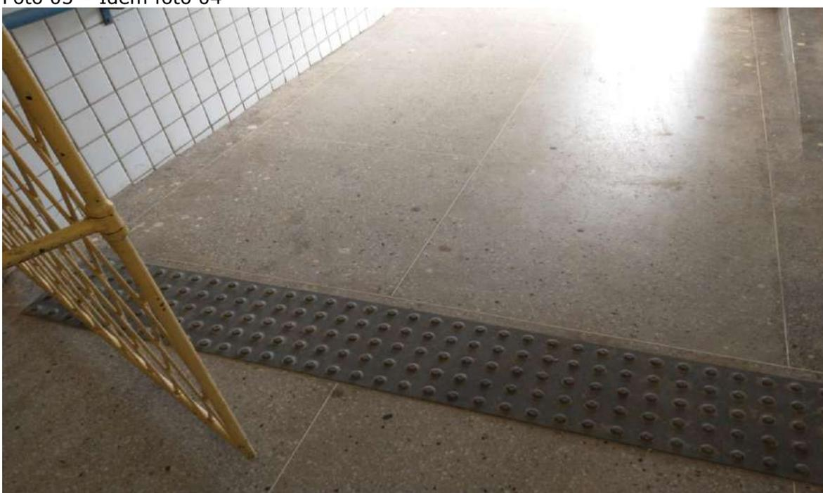
Foto 06 – Instalação de piso tátil
