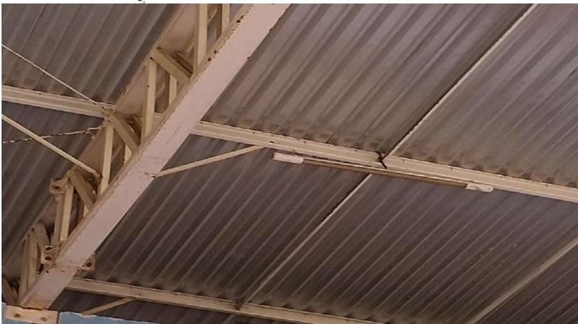
Foto 09 – Cobertura metálica em bom estado de conservação
